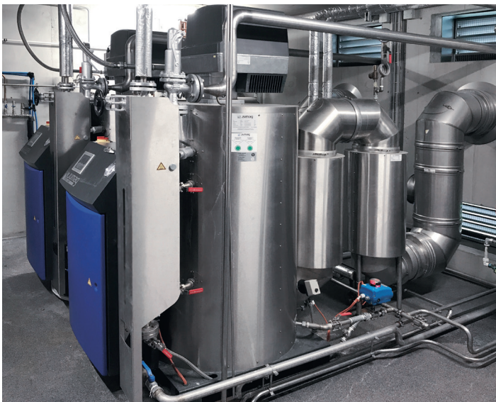
Ilustracja: System parowy z wieloma jednostkami. Drugi ekonomizer JUMAG zainstalowany na ramie podstawowej, zajmujący mało miejsca
